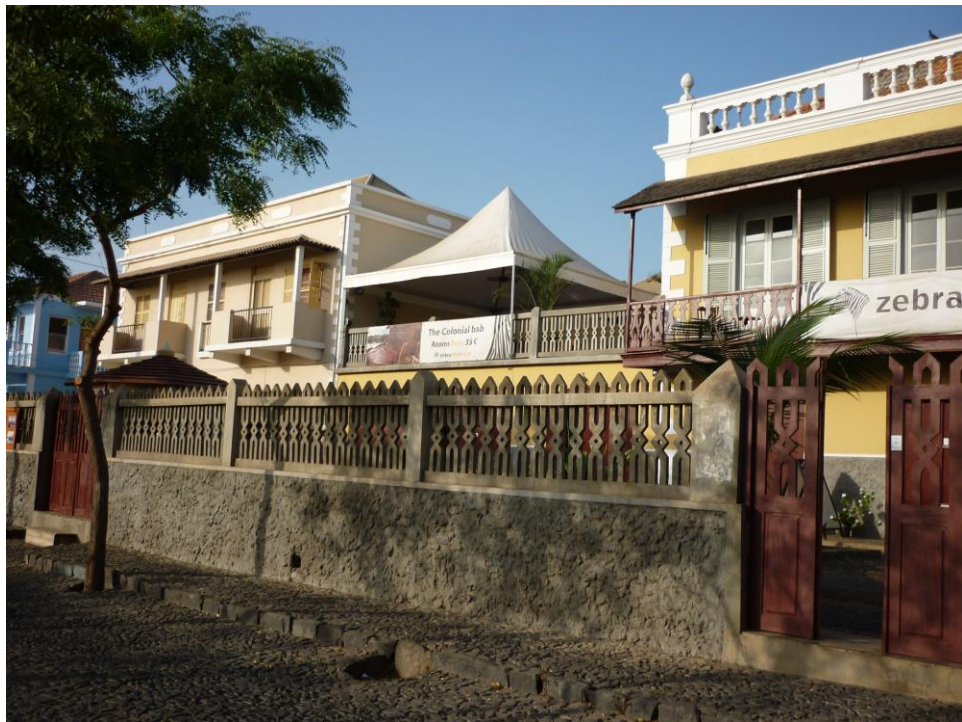
Figure 20 : Façade avec la partie du bâtiment vendue en premier avec l'architecture coloniale complètement modifiée
