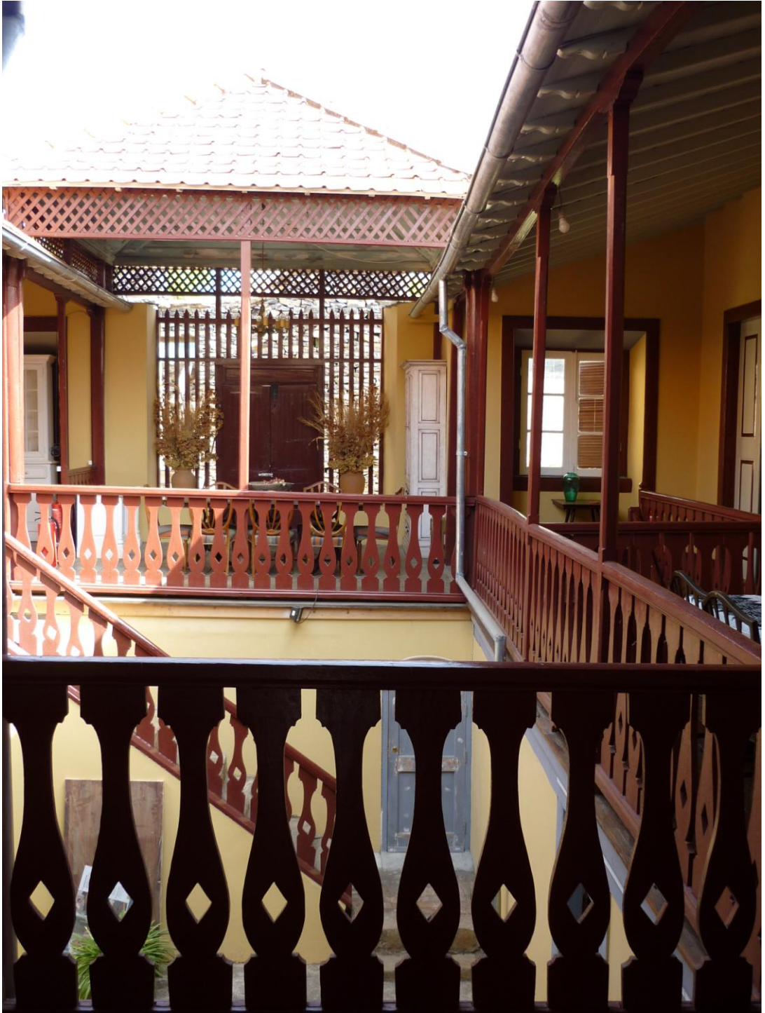
Figure 24: La balustrade en bois du 1 er étage
